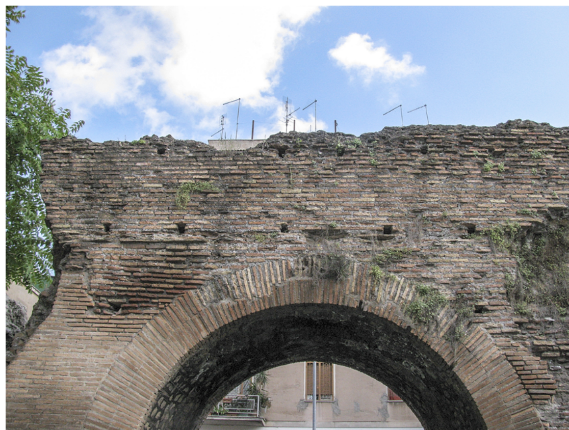
Via dei Pioppi, particolare di una bassa arcata e dello speco che vi correva sopra - foto di Ilenia Piccioni
