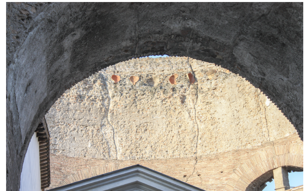
Mausoleo di Sant'Elena, particolare del tamburo con pignatte inglobate nel cementizio - foto di Elena Forniti
