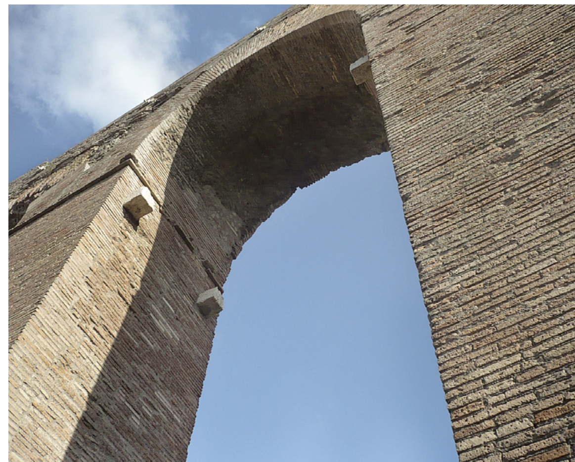
Acquedotto Alessandrino, particolare di arcata presa dal basso. Si evidenziano le mensole marmoree sporgenti ed il piano di spiccato dell'arco - foto di Michael Meloni
