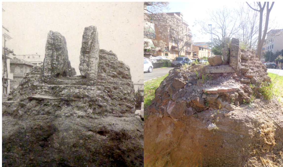
Fig.4a e Fig.4b - Sezione dello speco di via dei Pioppi prima del restauro eseguito negli anni '90 e come si presenta oggi (foto 1975-2013)
