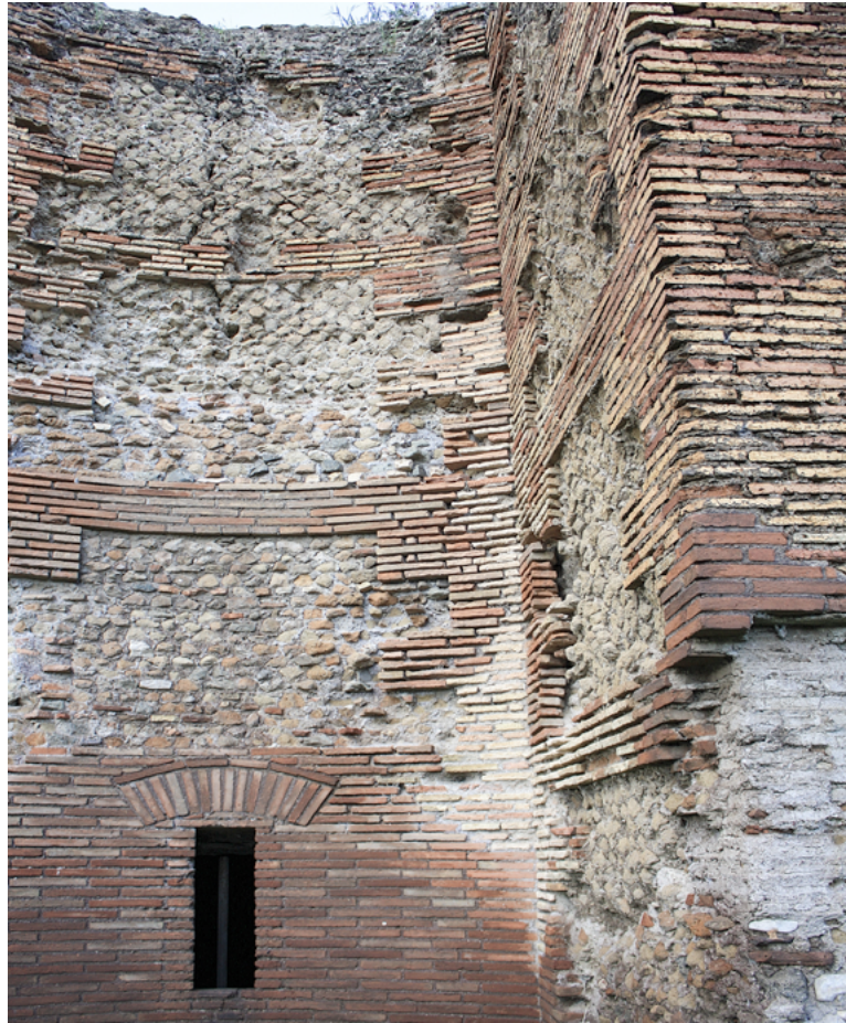
La Grande Cisterna: particolare della muratura in opus mixtum - foto di Elena Forniti
