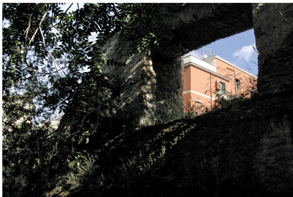
Acquedotto Alessandrino: l'arco non si vede più sostituito da una piattabanda che congiunge i due piloni e va a creare una sorta di finestra rettangolare - foto di Ilenia Piccioni
