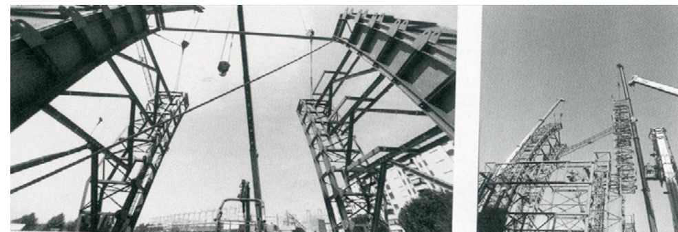
Fig.4 - Le Vele, la macchina per mettere in opera i “conci” (Falzetti 2003)
