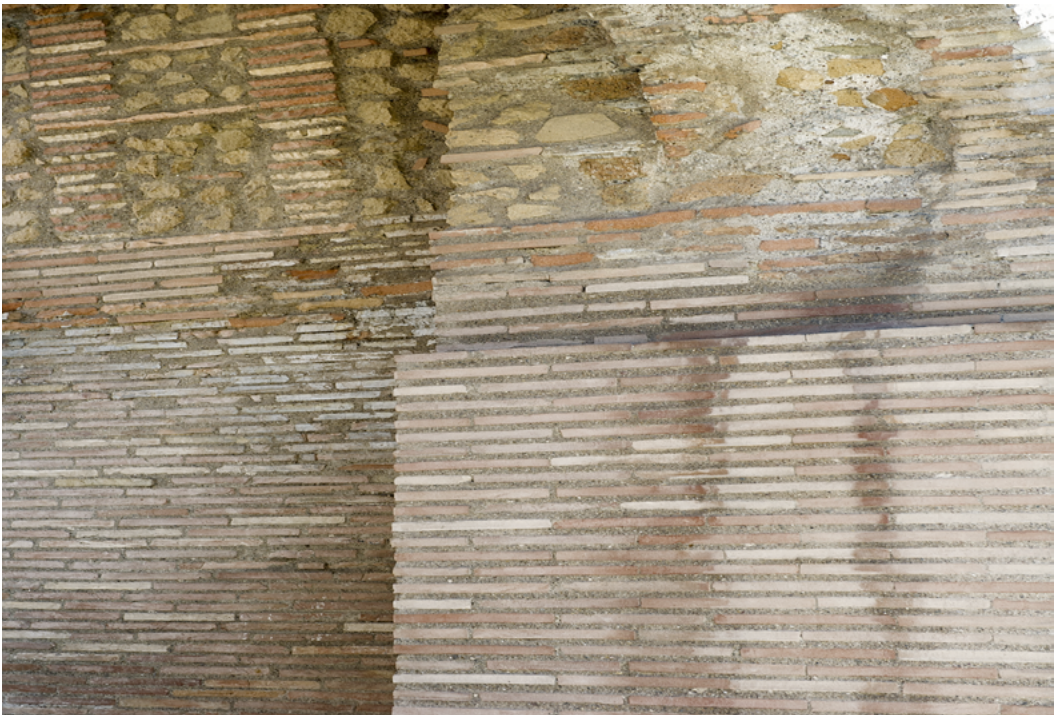
Acquedotto Alessandrino, particolare della tessitura muraria del pilone e dell'intradosso dell'arco che vi si poggia - foto di Antonio Tiso
