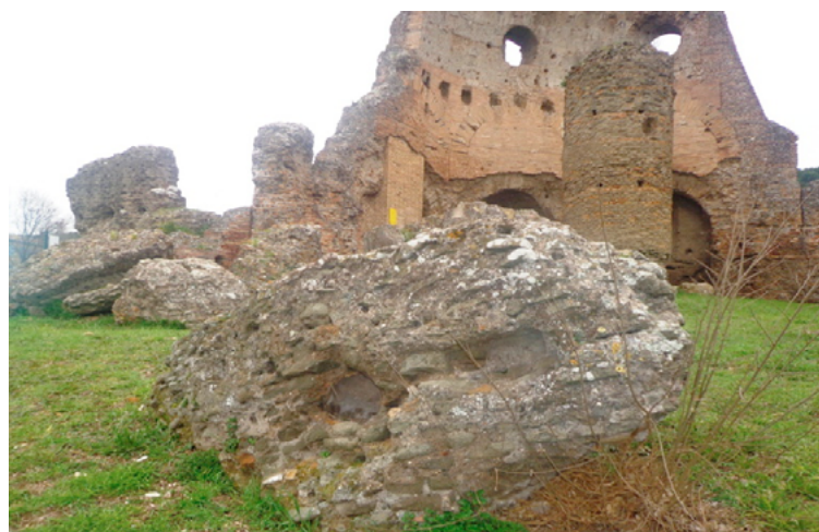
Aula ottagonata: particolare della volta crollata con tracce di anfore - foto di Silvia Pellegrini Rhao
